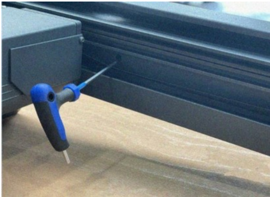
Abbildung 17: Fixierung der Führungsschienen
